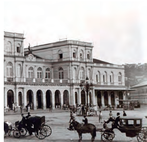
Estação Central da Antiga Estrada de Ferro Dom Pedro II (Rio de Janeiro/Brasil)
