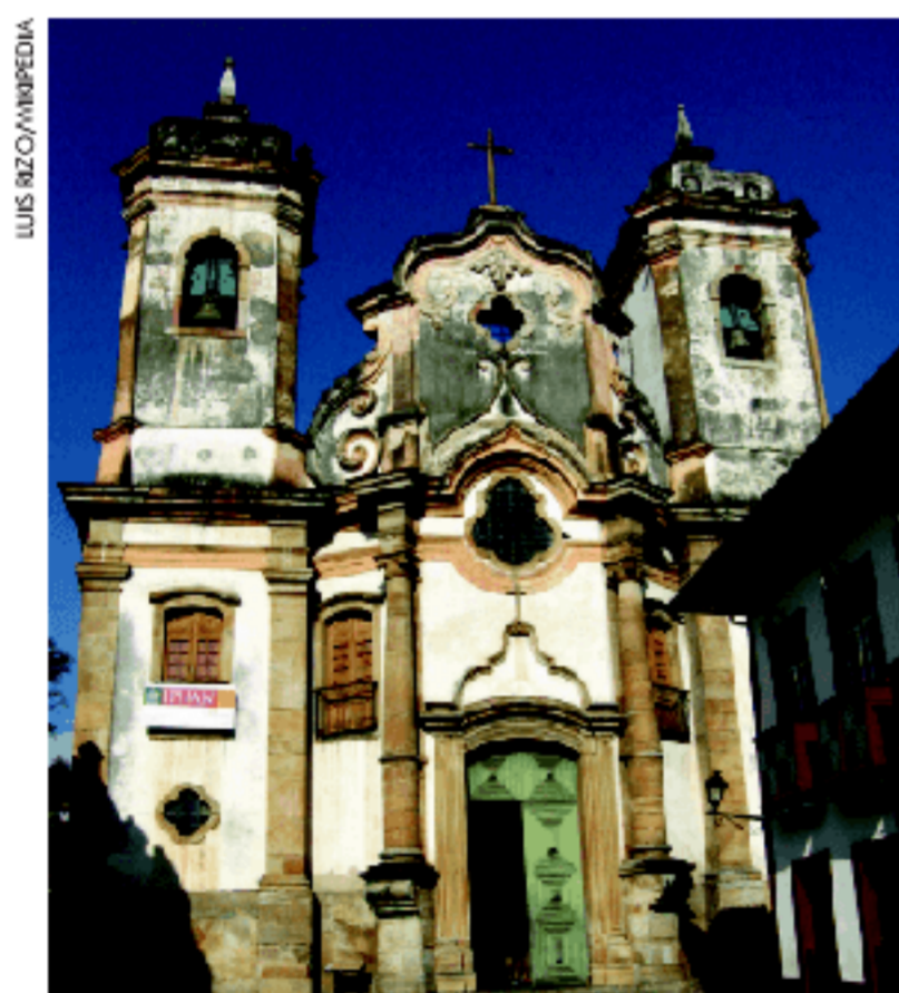
Fig. 26 Igreja Nossa Senhora do Pilar, Ouro Preto, Minas Gerais.
