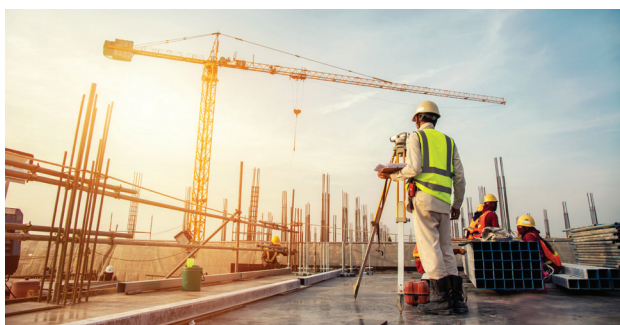
Teodolito é o instrumento utilizado para medição de ângulos.
