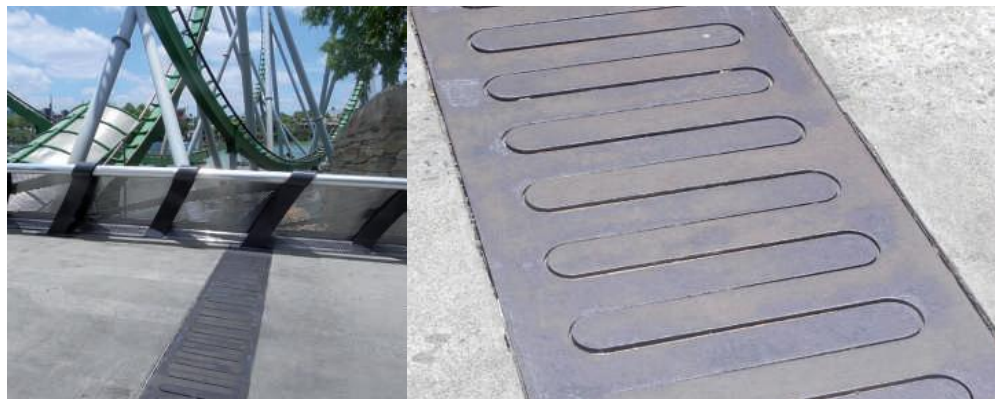
Fig. 16 Junta de dilatação em uma ponte. Parque Universal Studios – Flórida, Estados Unidos.
