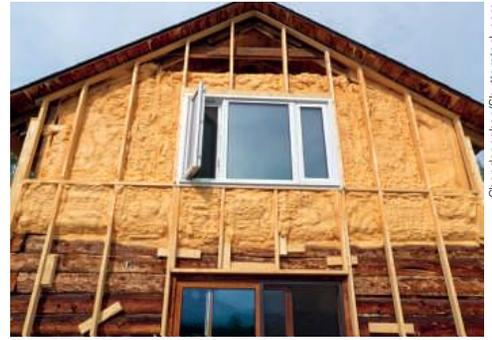
Espuma de poliuretano usada como isolante.
