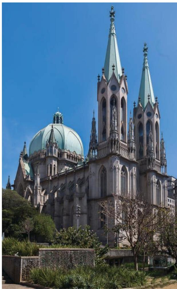
As cúpulas da Catedral da Sé, de São Paulo, são revestidas pelo produto da oxidação natural do cobre em contato com ar atmosférico úmido.
