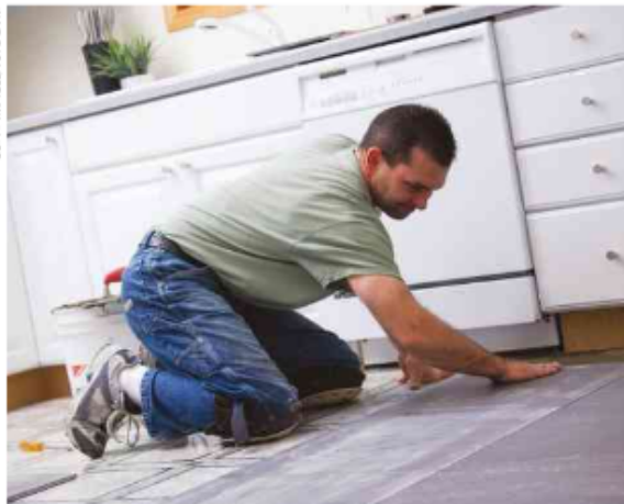
Colocação de pisos.
