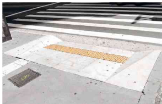
Rampa de baixa inclinação com piso tátil.
