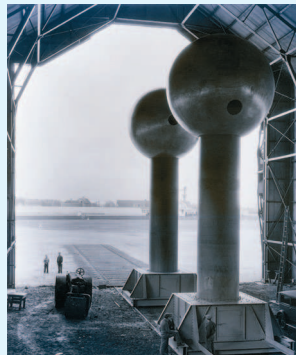
Um dos primeiros modelos de gerador eletrostático construídos por Van de Graaff no MIT (Instituto Tecnológico de Massachusetts).
