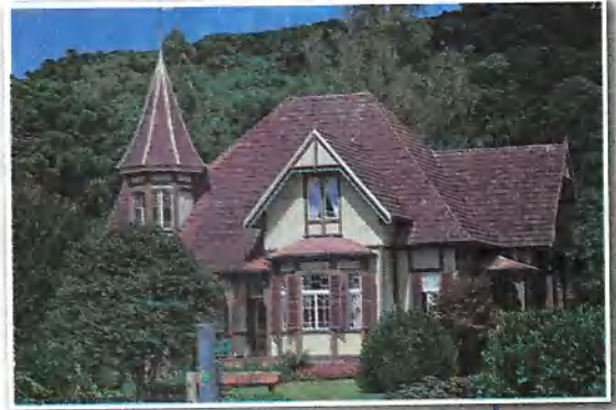
Castelinho Caracol, arquitetura de influência alemã, construída em 1913, em Canela, 2011
