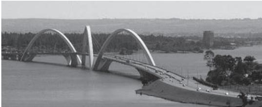
A estrutura da ponte conta com três arcos parabólicos, que sustentam, por meio de cabos de aço, três tabuleiros com vão de 240 metros cada um, e altura aproximada de 60 metros acima do nível do lago, apoiados em quatro bases submersas. A figura representa, matematicamente, um dos arcos parabólicos.
