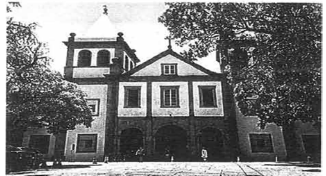
Mosteiro de São Bento (RJ)
