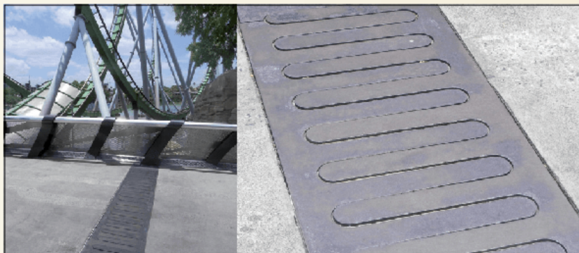
Junta de dilatação em uma ponte. Parque Universal Studios – Florida-USA.
