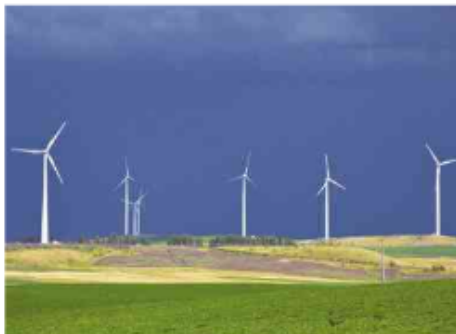
Parque Eólico de Água Doce. Água Doce-SC. Fevereiro de 2014.
