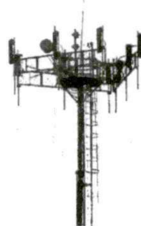
Figura 1.6 - Torre de ERB com antenas.
