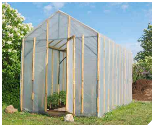
Estufa de baixo custo. Em vez de vidro, é coberta com plástico.
