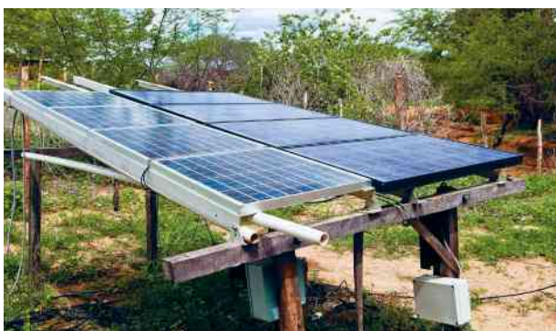
Figura 5.5 As células fotovoltaicas podem ser uma solução para a eletrificação rural. Independência (CE), 2013.
