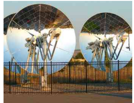
Figura 5.8 Aquecedor solar parabólico, que pode chegar a fornecer água no estado de vapor.
