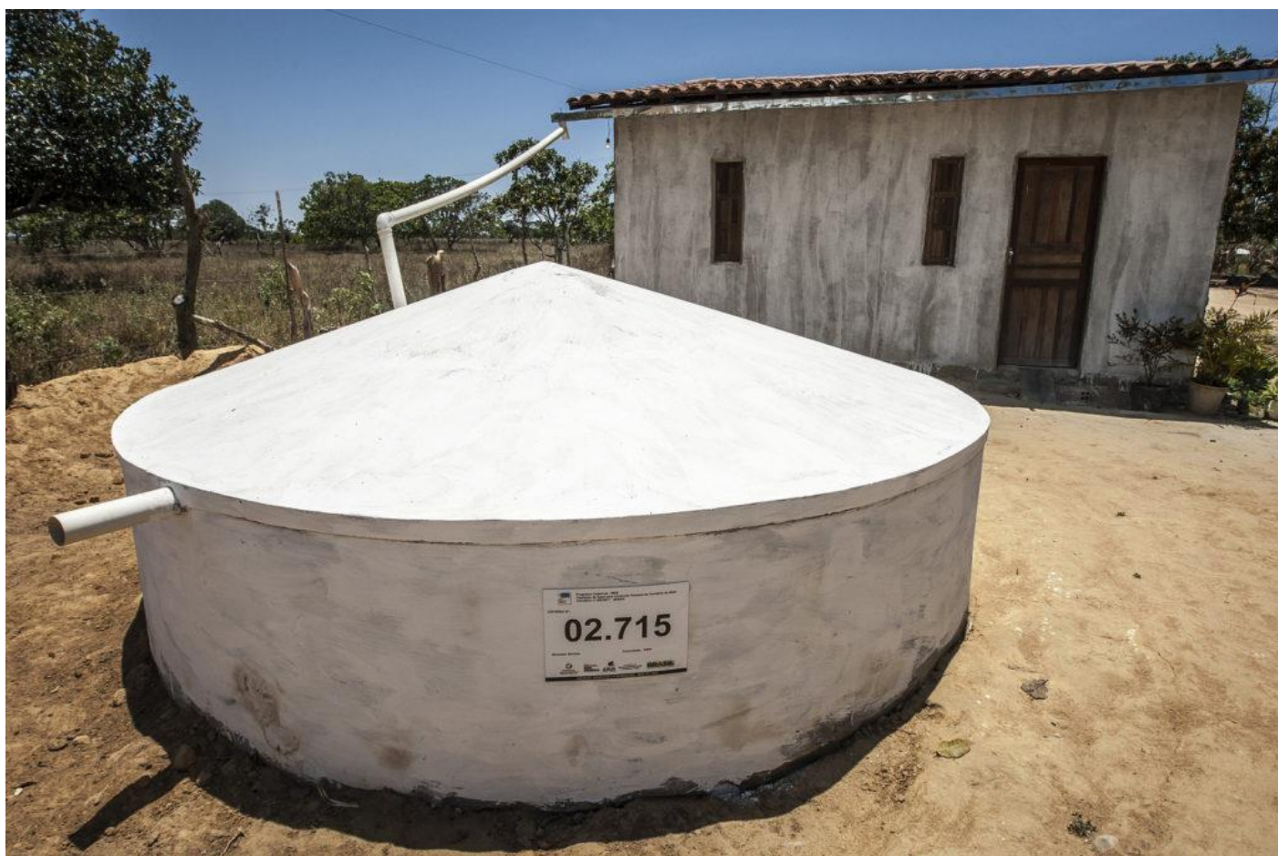
Figura 20 – Cisterna Fonte: CMA-CBIC
