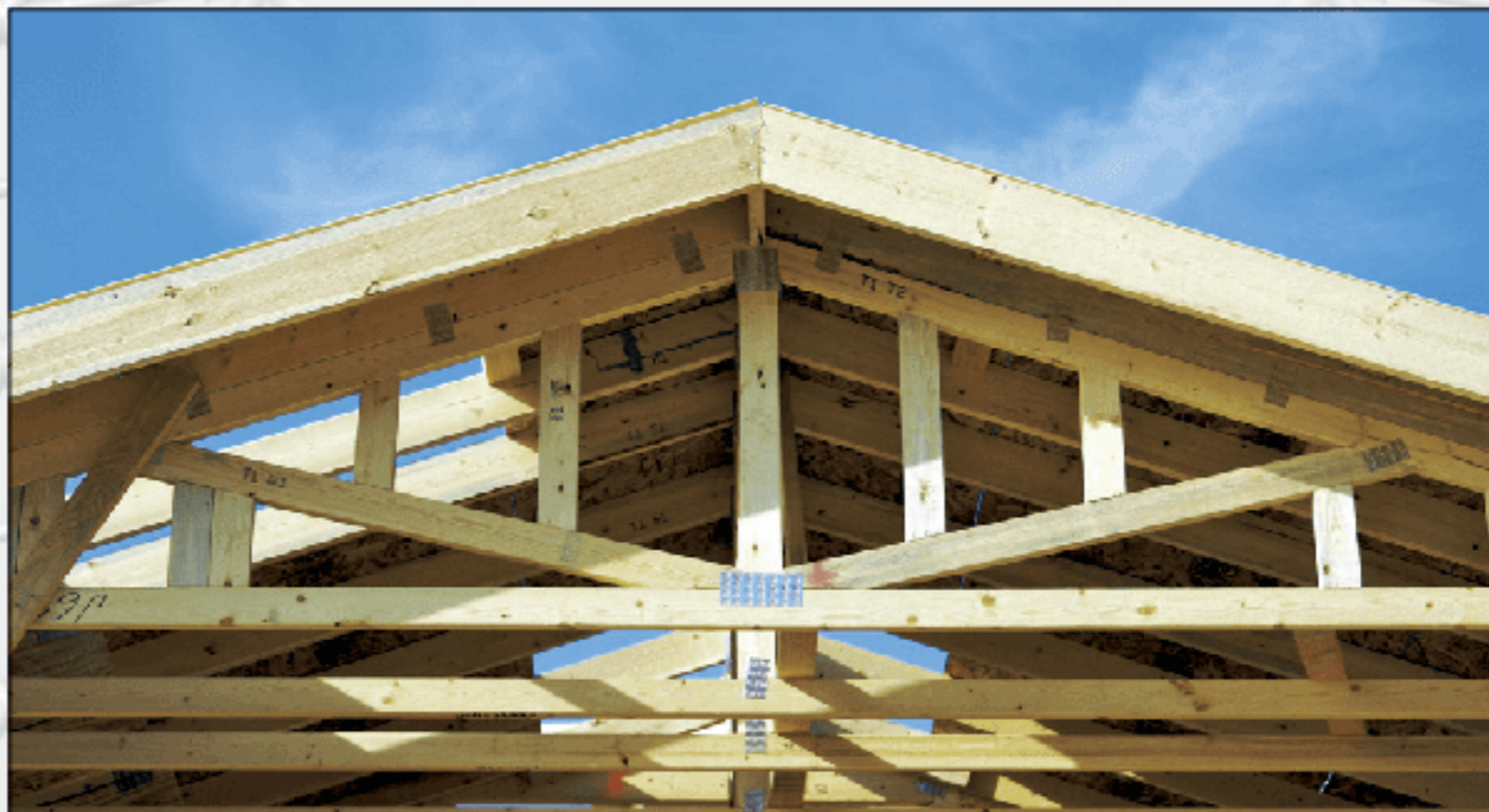
Cobertura de uma habitação.
