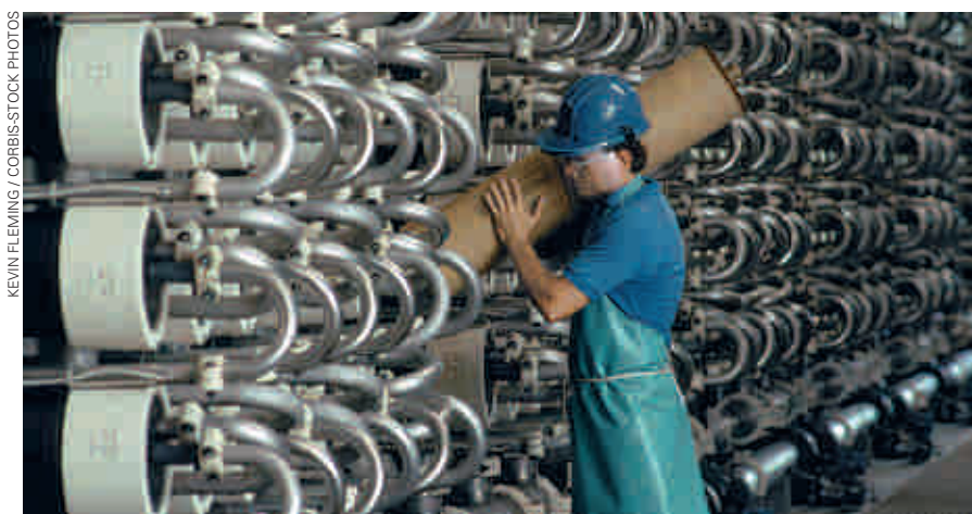
Unidade de dessalinização de água por osmose reversa.
