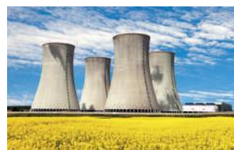
Torres de refrigeração de usina nuclear
