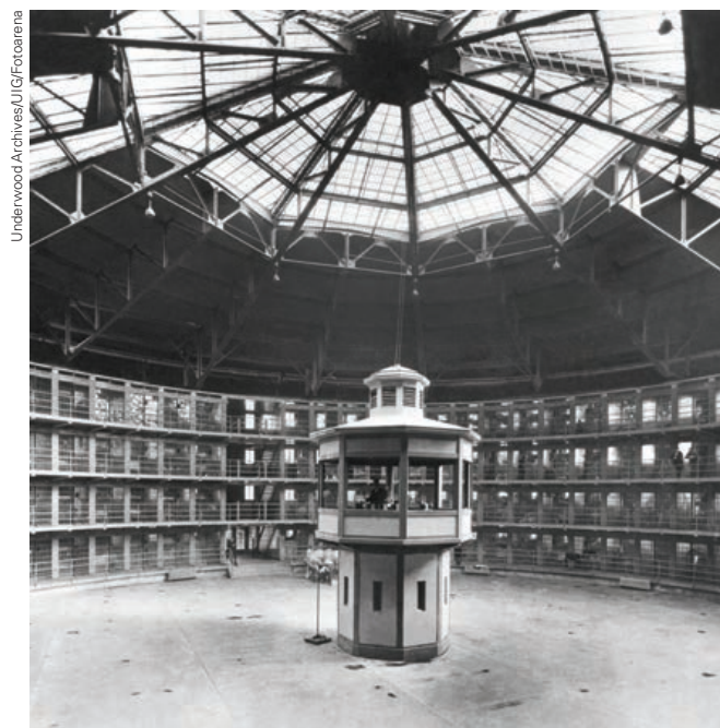
Estrutura do panóptico para presídios, idealizado por Bentham: torre central permite a vigilância constante dos prisioneiros dispostos em celas, em uma estrutura circular.
