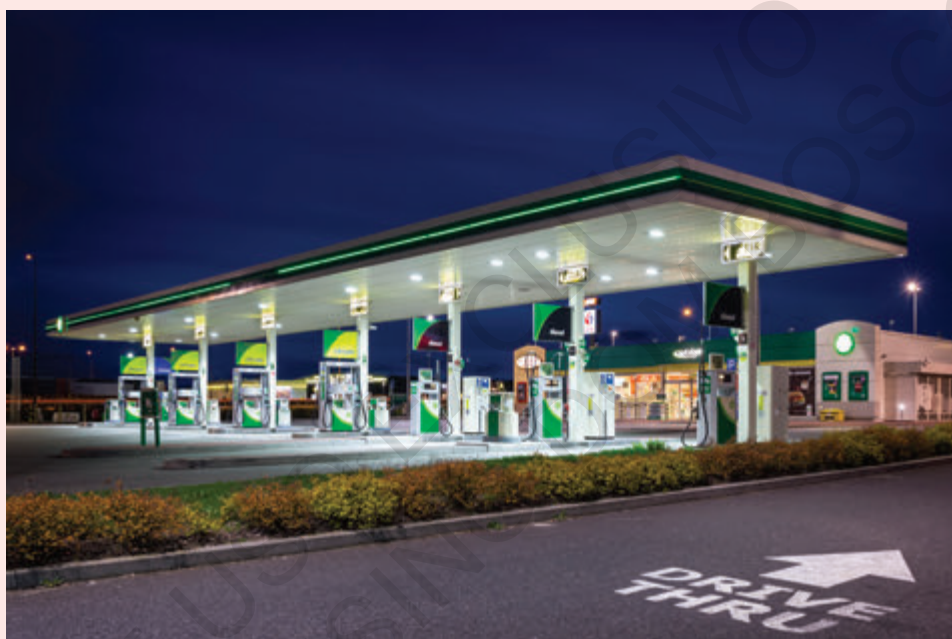
Posto de gasolina em cujos tanques subterrâneos ocorre dilatação volumétrica.
