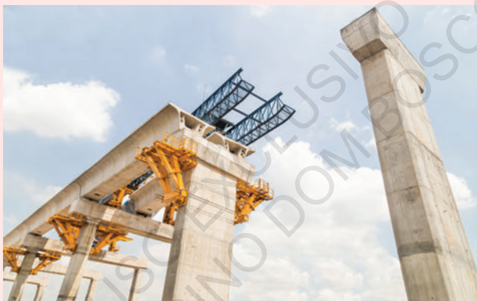
Pontes de concreto são construídas por blocos um do lado do outro, deixando-se espaço entre eles. O motivo disso é que a maioria dos materiais se dilata com o aumento de temperatura.
