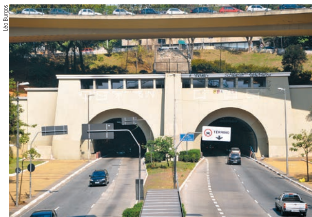
◆ Arcos do Túnel Daher Elias Cutait, antigo Túnel Nove de Julho. São Paulo, 2011.
