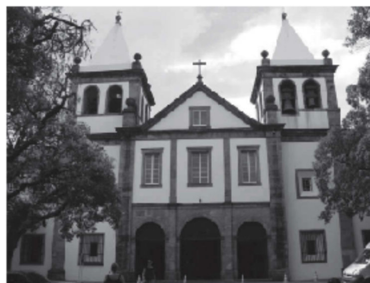
Mosteiro de São Bento (RJ)
