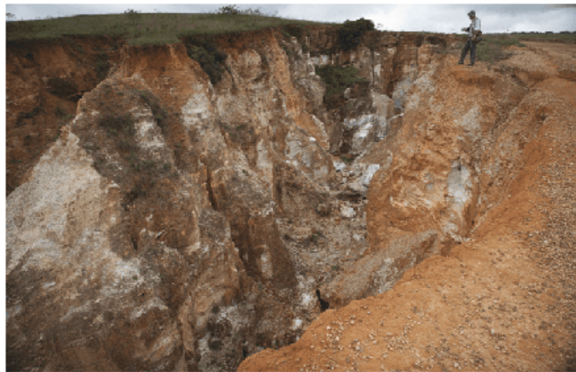
Fig. 4 Voçoroca na Serra do Cipó, Minas Gerais. As voçorocas são consideradas um dos estágios mais graves do processo de erosão.
