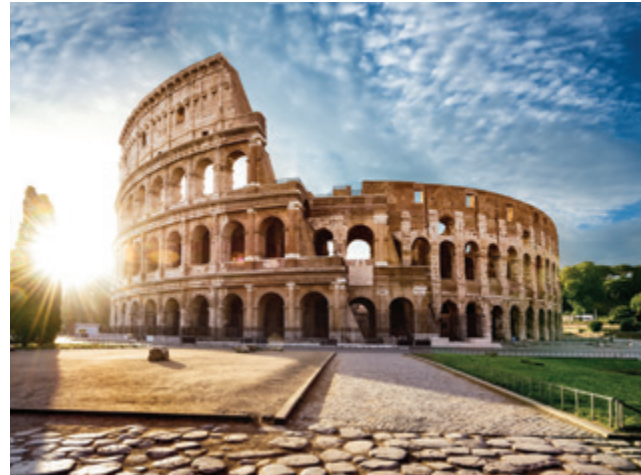
O Coliseu, construído no século I d.C., em Roma, possuía quatro pavimentos de sustentação. Nos três primeiros, estão as fileiras de arcos.
