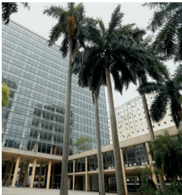
Palácio Capanema, no Rio de Janeiro, exemplo de arquitetura modernista. O prédio foi projetado por Lúcio Costa, Carlos Leão, Oscar Niemeyer, Affonso Eduardo Reidy, Ernani Vasconcellos e Jorge Machado Moreira. O jardim-terraço é de Burle Marx.
