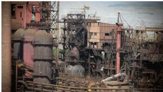
CINTURÃO DA FERRUGEM
