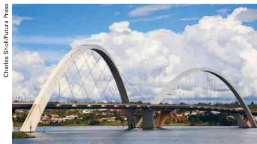
Ponte Juscelino Kubitschek, em Brasília. Fotografia de 2015. (Detalhe)
