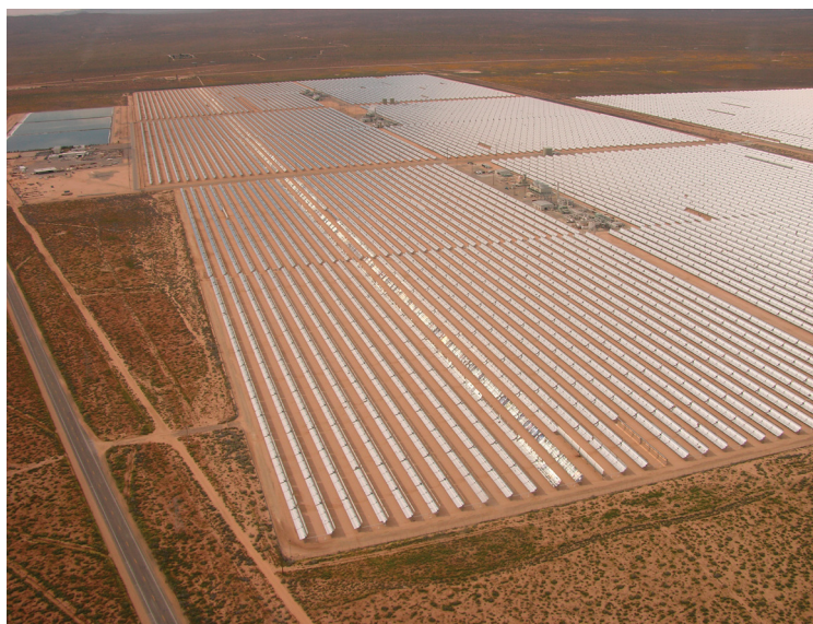
Painéis solares no Deserto de Mojave, na Califórnia, EUA.
