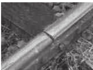
a dilatação ou contração térmica é “facilitada” para evitar problemas desse tipo. Nas ferrovias, por exemplo, as barras de trilho devem ser assentadas com um espaço entre elas. Nos calçamentos, separam-se as placas de cimento por ripas de madeira ou varas de plástico, que “absorvem” eventuais dilatações das placas.
