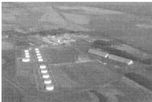
FIGURA 2 - Usina de Álcool São Martinho Estado de São Paulo
