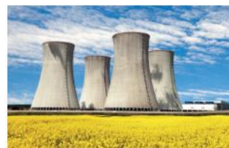
Torres de refrigeração de usina nuclear.
