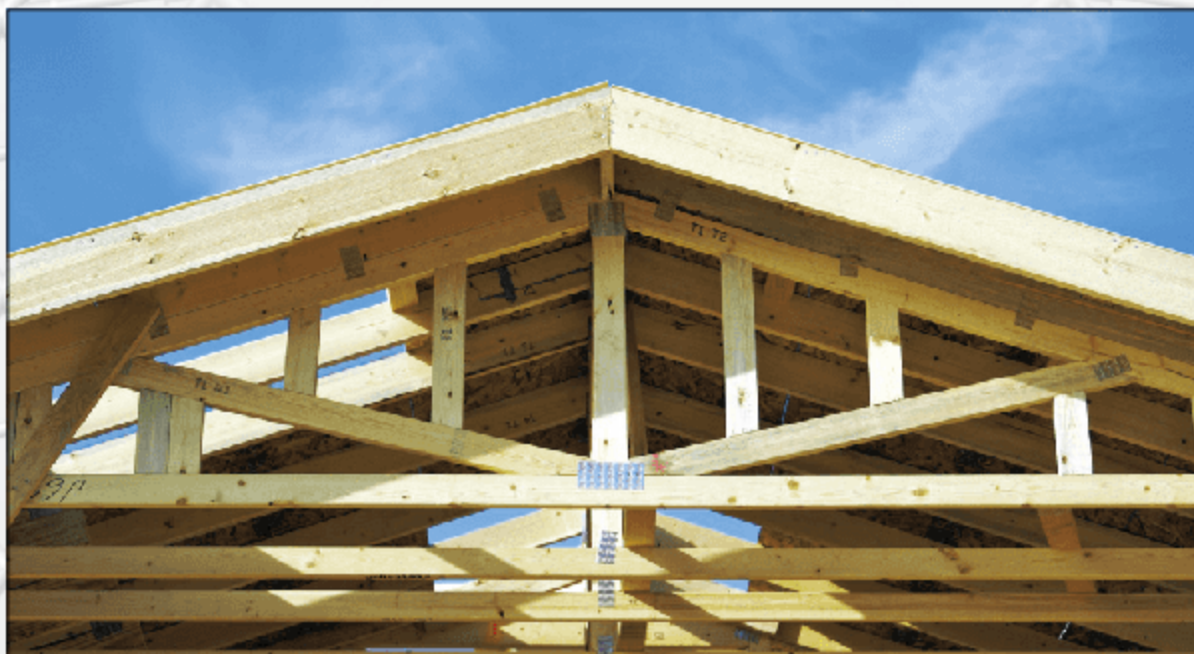
Cobertura de uma habitação.
