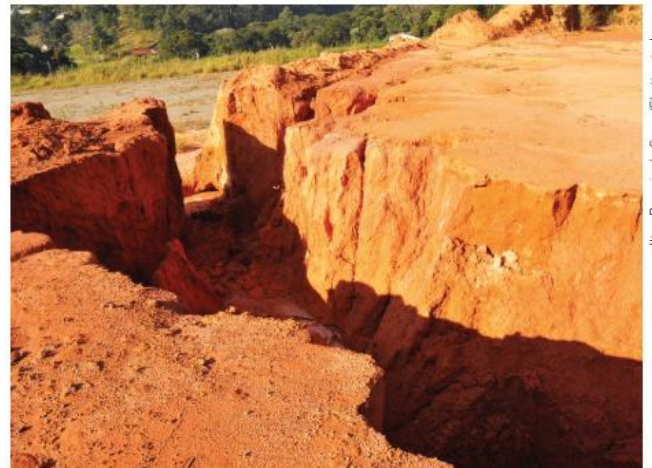
Voçoroca em São Roque (SP). As voçorocas são consideradas um dos estágios mais graves do processo de erosão.
