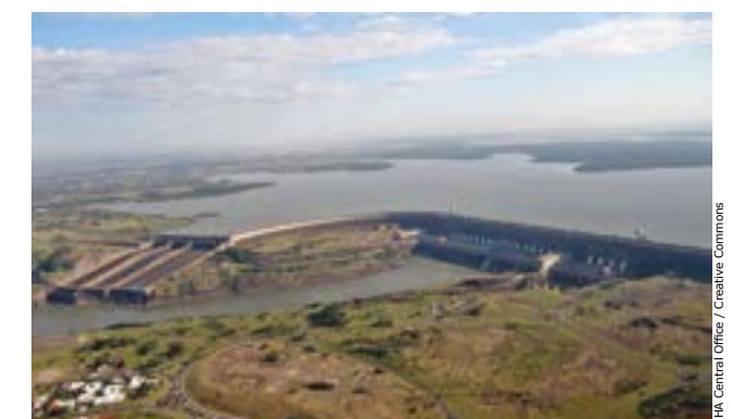
Hidrelétrica de Itaipu.
