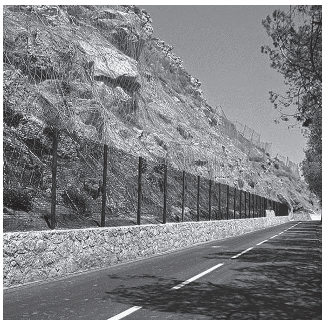
Contenção de talude.
