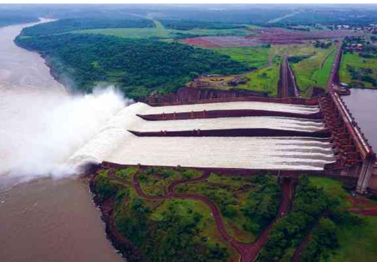
Em novembro de 2015, após uma grande cheia, Itaipu teve de abrir todas as comportas das três calhas de escoamento de água. Com o reservatório cheio, a usina precisa escoar o excedente de água não usado para a produção de energia elétrica. Geralmente só uma ou duas calhas são abertas para escoar o excedente de água.
