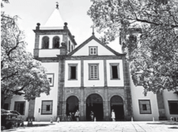
a. Mosteiro de São Bento (RJ)
