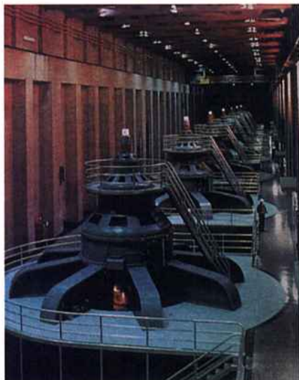
Fig. 24-14: Conjunto de geradores que transformam a energia mecânica de uma queda-d'água em energia elétrica.
