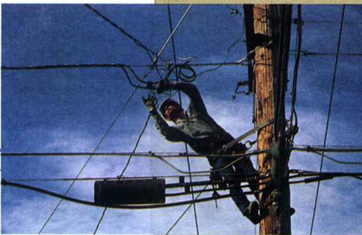
Fig. IV: O técnico da companhia de eletricidade não sofrerá dano se tocar apenas num desses cabos da linha de alta voltagem (estando isolado da Terra).
