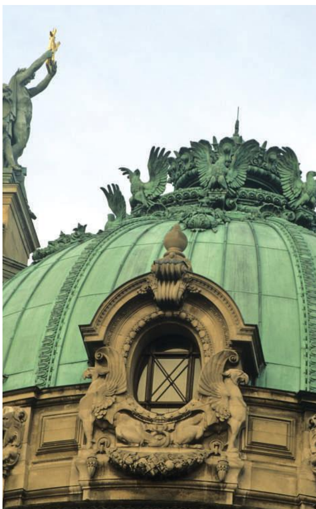
Fig. 21 Cúpula da Opera House de Paris, recoberta por \text{CuCO}_3 \cdot \text{Cu}(\text{OH})_2(\text{s}) .
