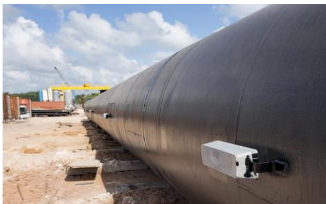
Fig. 24 Instalação de metal de sacrifício em tubulação de ferro.
