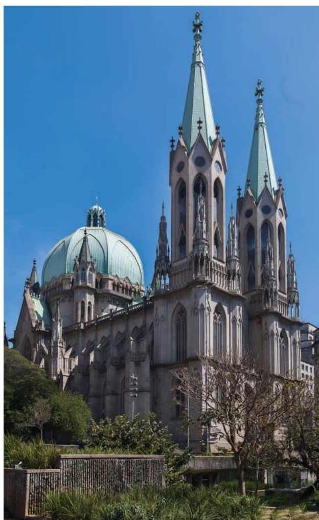
Fig 22 As cúpulas da Catedral da Sé, de São Paulo, são revestidas pelo produto da oxidação natural do cobre em contato com ar atmosférico úmido
