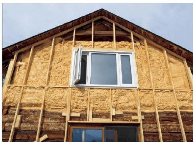
Fig. 62 Espuma de poliuretano usada como isolante.
