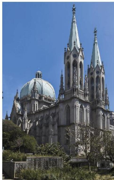
Fig. 22 As cúpulas da Catedral da Sé, de São Paulo, são revestidas pelo produto da oxidação natural do cobre em contato com ar atmosférico úmido.
