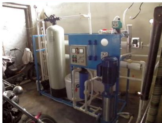
Aparelho de osmose reversa.
