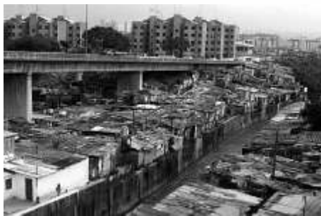
Favela Tiquatira, na marginal Tietê, sob o viaduto General Milton de Souza.
