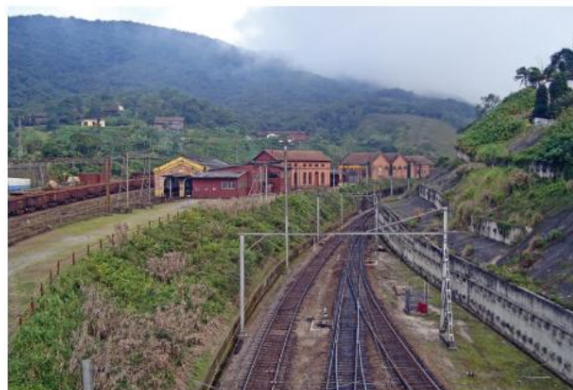
Antiga estação ferroviária que impulsionou a fundação da vila de Paranapiacaba, que atualmente é um distrito do município de Santo André (SP).
