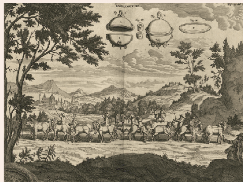
Fig. 9 Desenho feito por Gaspar Schott, em 1672, do experimento dos hemisférios de Magdeburgo.
