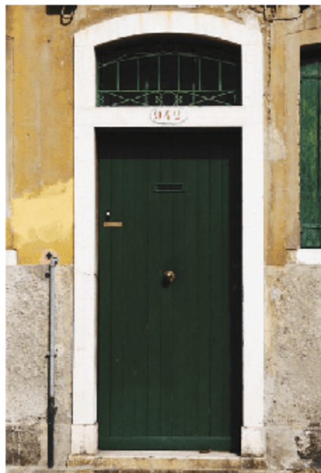
Fig. 21 Será que é eficiente posicionar a maçaneta no meio de uma porta? Nesse caso, para abri-la é necessária a aplicação de uma força maior do que se a maçaneta fosse posicionada na extremidade oposta às dobradiças.
