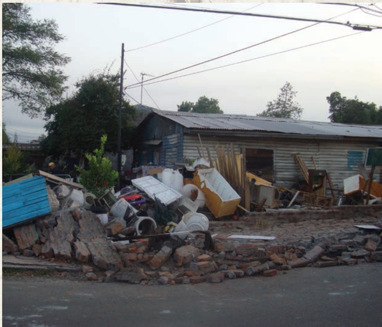
Residência destruída pelo terremoto de 2010
