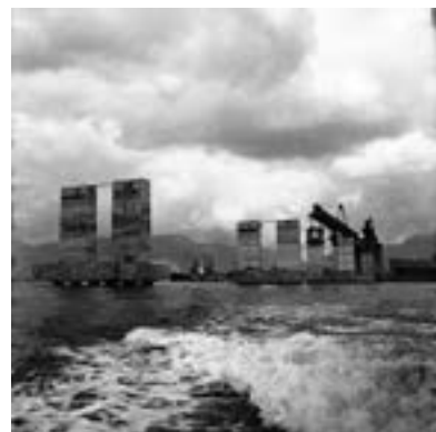
Construção da Ponte Rio-Niterói, uma das obras faraônicas do Regime Militar.
