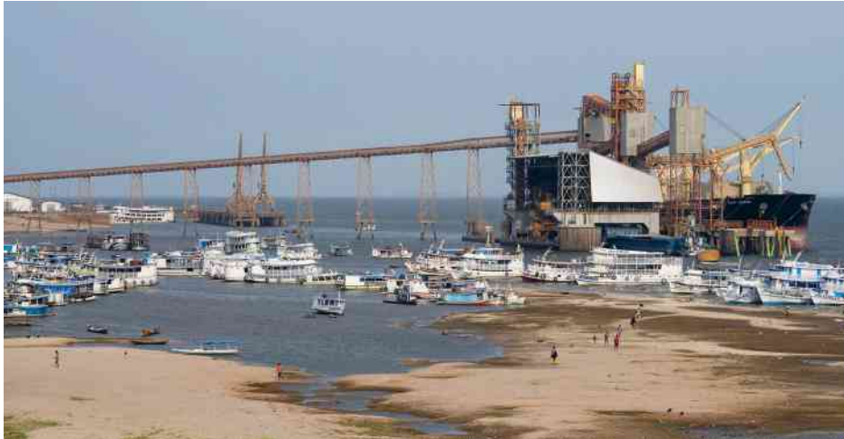
Figura 32. Terminal de embarque de grãos no Rio Tapajós, em Santarém (PA), 2015. No entorno do Rio Tapajós instalaram-se fazendas, grande parte delas voltada para o cultivo de soja, escoada pelo terminal. Segundo a moratória da soja – acordo entre sociedade civil, setor produtivo e governo, que visa eliminar o desmatamento da cadeia de produção da soja na Amazônia –, em vigor desde julho de 2006, empresas não podem comercializar ou financiar a soja e seus derivados provenientes de áreas desmatadas no bioma Amazônia após maio de 2008, dentro de terras indígenas ou que estejam na lista de trabalho escravo. Em maio de 2016, a moratória foi renovada por prazo indeterminado.
