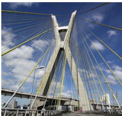
Fig. 2 A Ponte Estaiada Octavio Frias de Oliveira, em São Paulo, é uma bela construção da engenharia e da arquitetura que usa aspectos da Estática.
