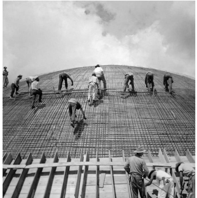
Figura 11 - Construção da cúpula do Senado, Brasília. Fotografia de Marcel Gautherot.
