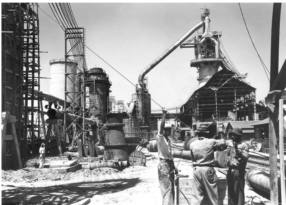
Figura 6 - Construção da usina de Volta Redonda, da Companhia Siderúrgica Nacional. Fonte: Memorial da Democracia.
