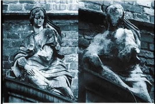
Figura 13 - Estragos causados pela chuva ácida em uma estátua
